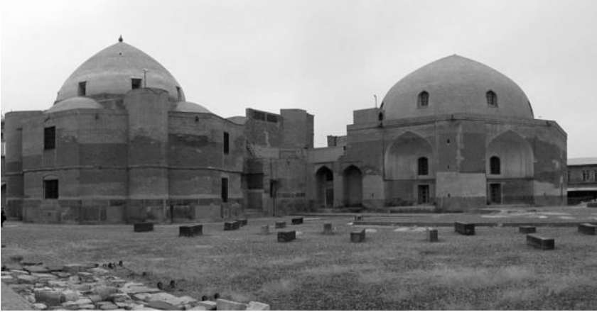
Şəkil-17. Şeyx Səfi məqbərə kompleksinə daxil olan Şəhidgahın ümumi görünüşü.
