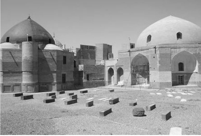
Şəkil-55. Şəhidgahın müasir görünüşü
