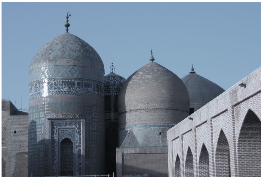
Şəkil-47. Şeyx Səfi məqbərə kompleksinə daxil olan günbəzlərin ümumi görünüşü
